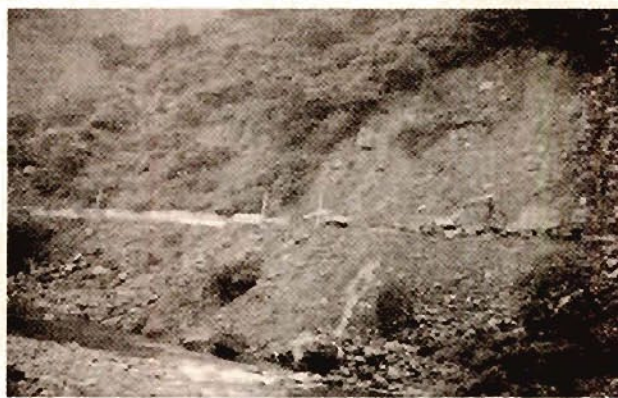
颱風後南隘寮溪沿岸山壁崩塌景況 圖\台大城鄉所
